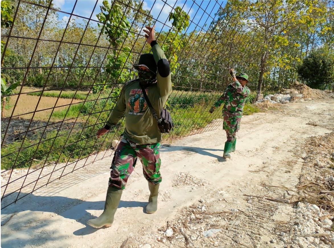
Menurut Peltu Saiful meskipun hanya untuk sementara, pemasangan besi bekisting dan ram besi penguat cor harus benar dan tepat supaya diperoleh bangunan yang berkualitas. Kuatnya beton jalan tak hanya bergantung pada konstruksi beton yang baik, tetapi juga dalam pemasangan bekisting.
